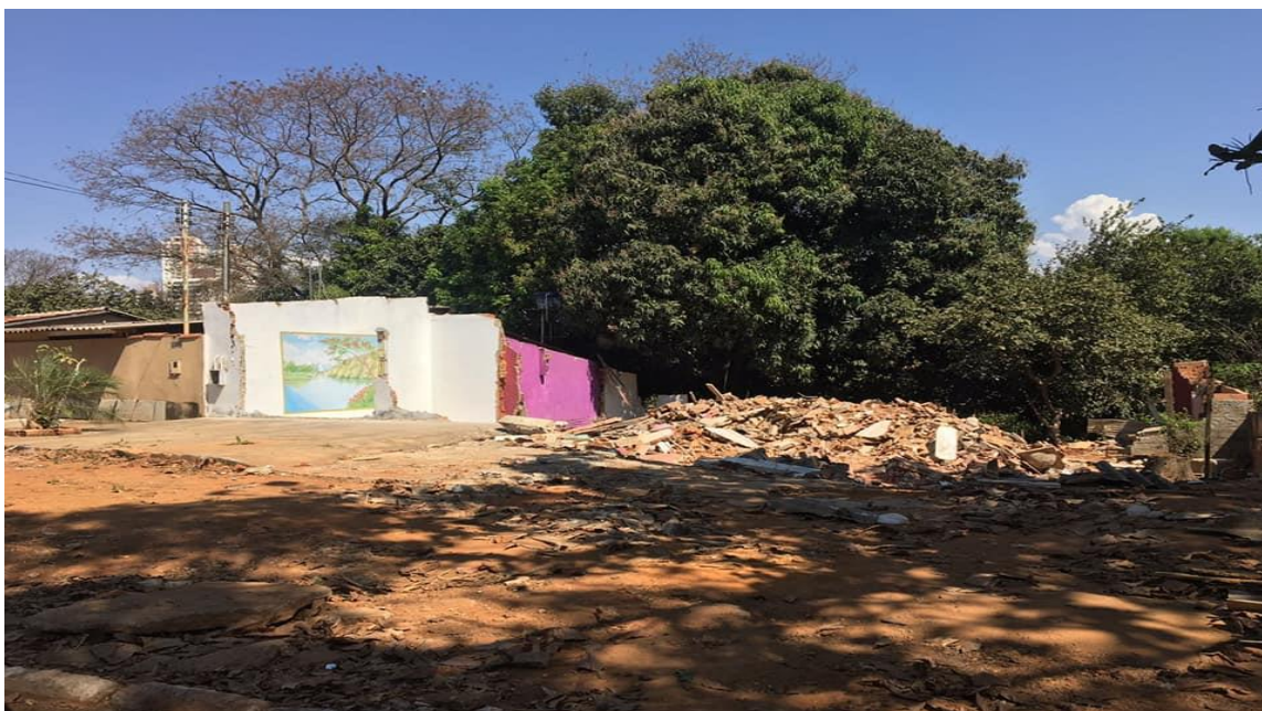
Uma das 5 casas demolidas na Av. Piratininga.
