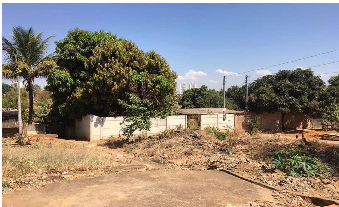
Uma das 5 casas demolidas na Av. Piratininga.
