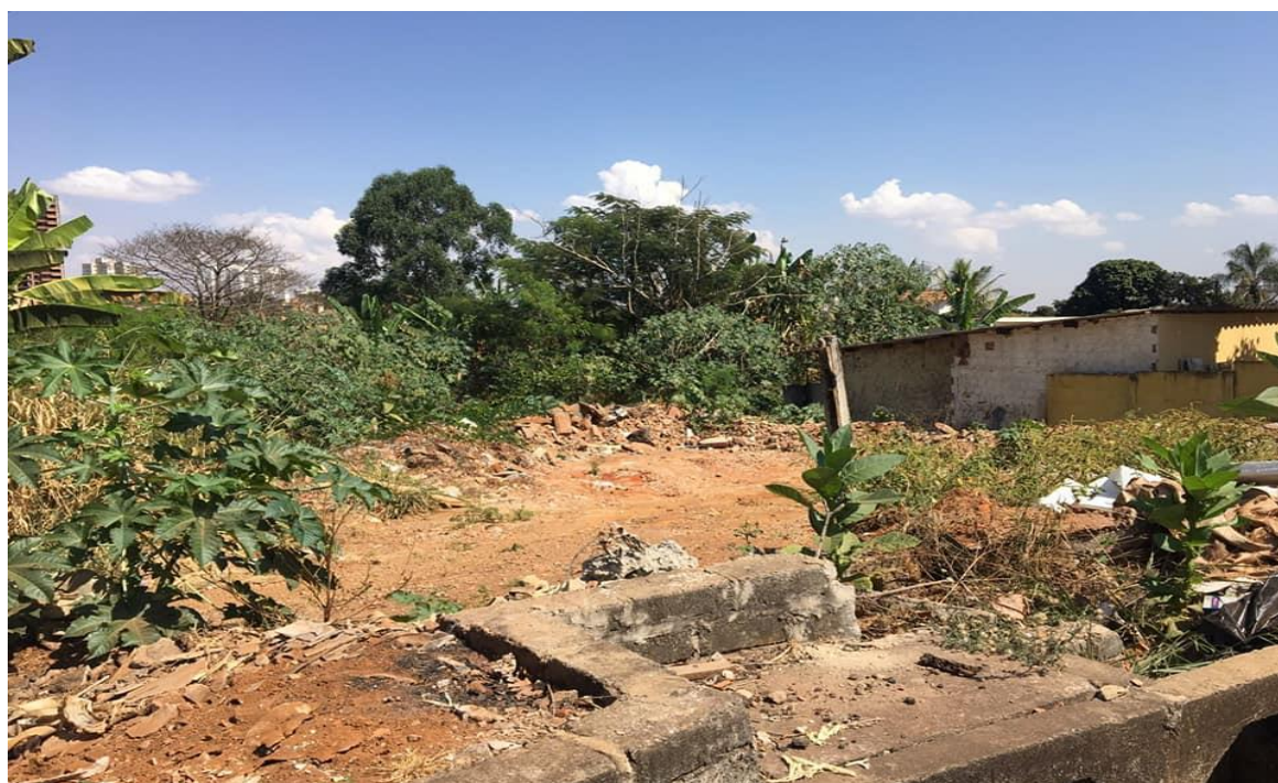
Uma das 5 casas demolidas na Av. Piratininga.
