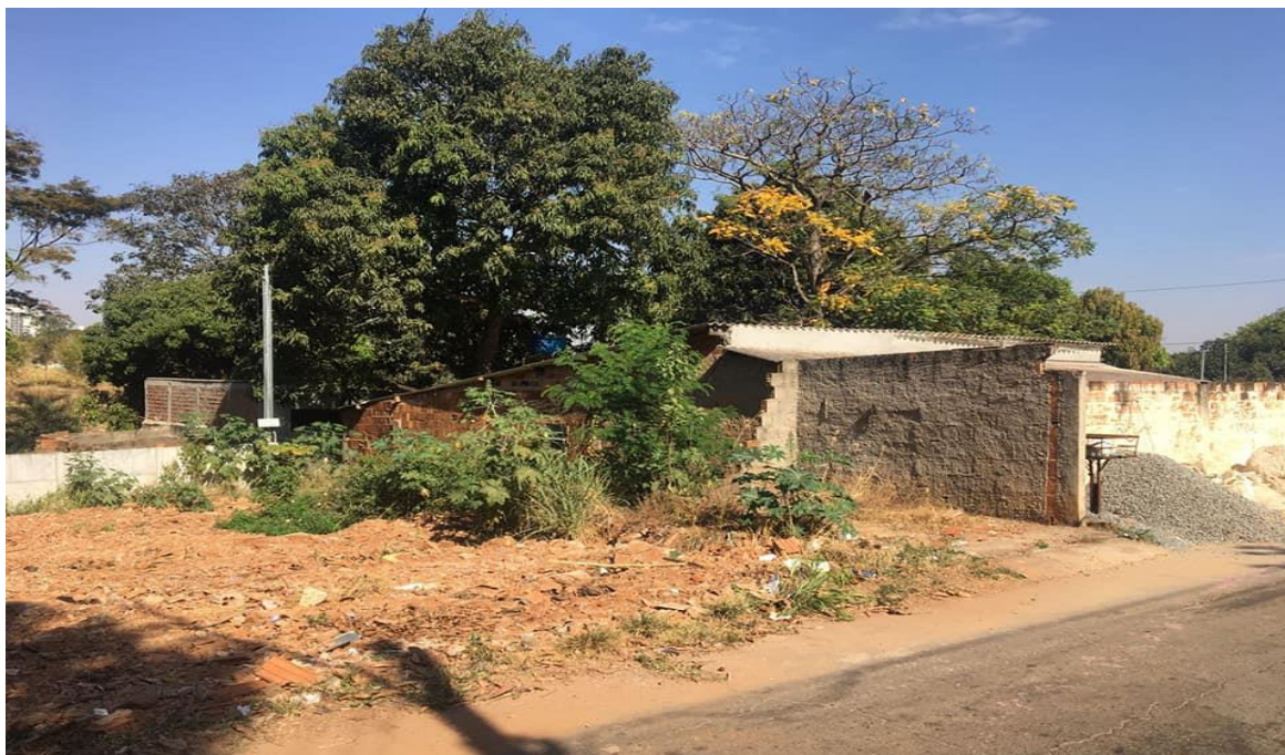
Uma das 5 casas demolidas na Av. Piratininga.
