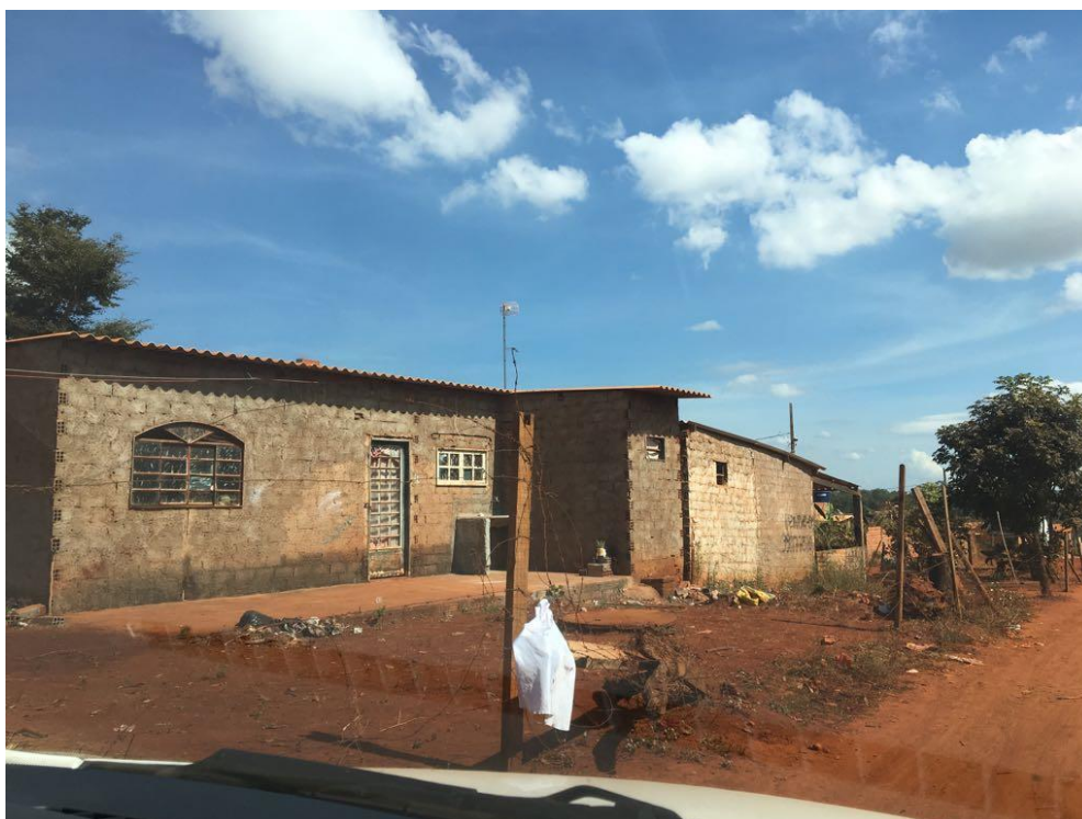
Casa de alvenaria sem reboco
